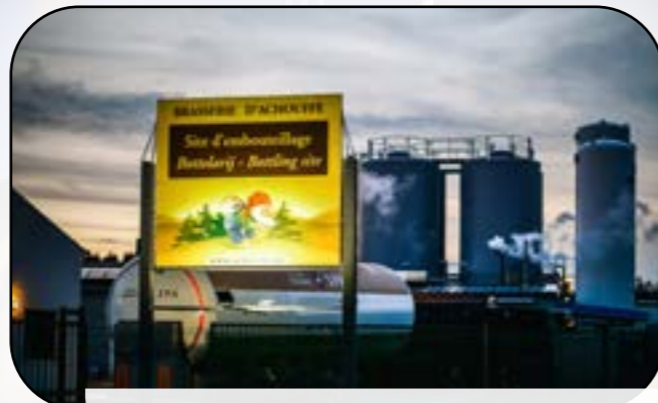
Éclairage d'un parking pour le personnel de la brasserie d'Achouffe
