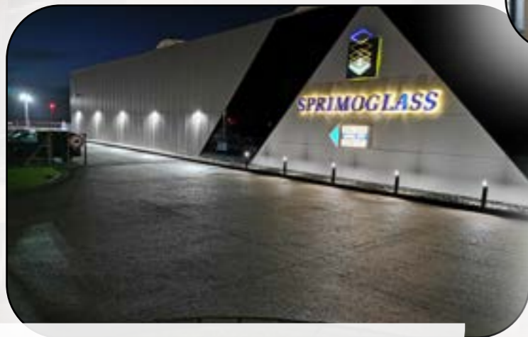
Étude, fourniture et placement d'éclairages LED pour la société Sprimoglass
